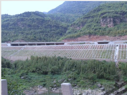
高填深挖的路基
