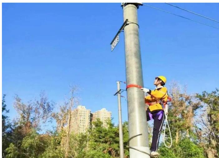
图 18 欧智媛在高空练习接地封线
