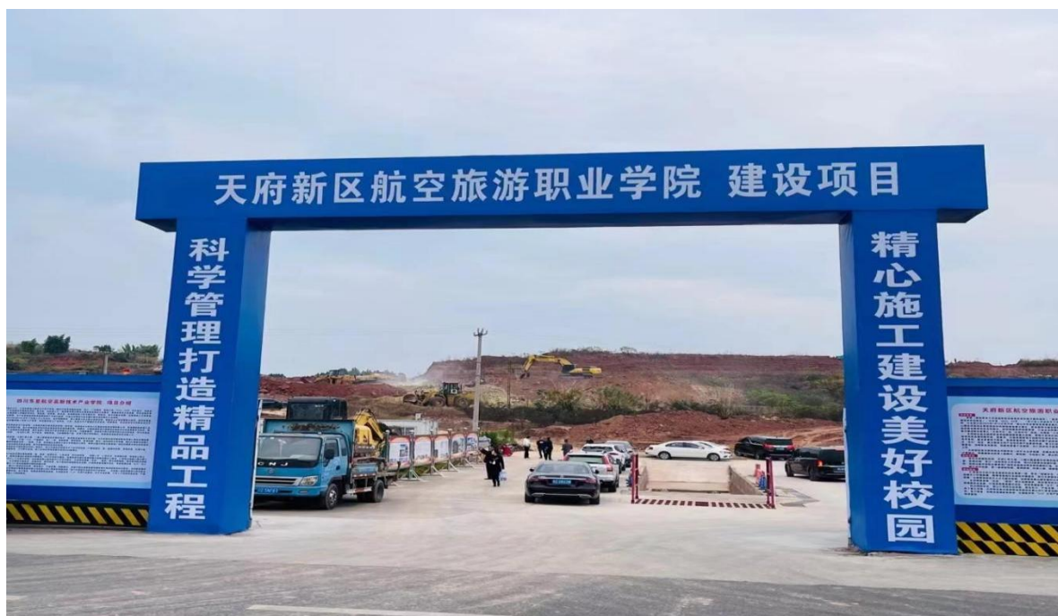
图 1 仁寿（在建）新校区建设
