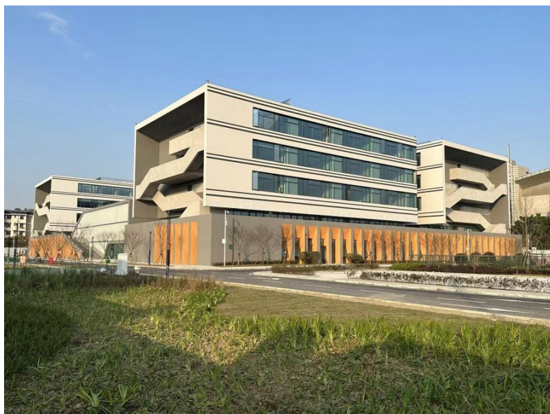
图 1-8：新建太平寺校区教学综合楼实景
