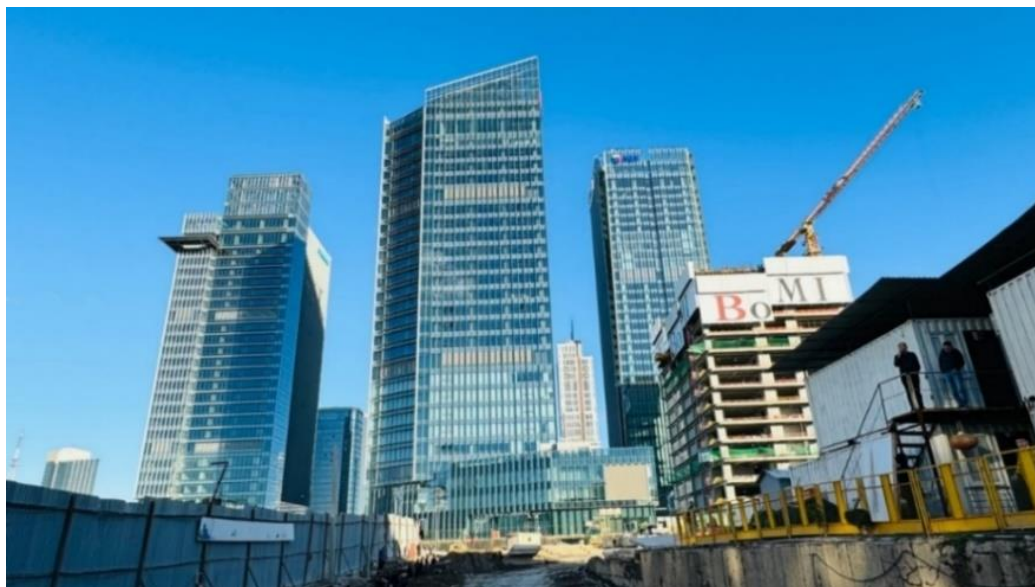
图 4.1 乌兹别克斯坦塔什干银行总部超高层建筑项目（2018-2024）
