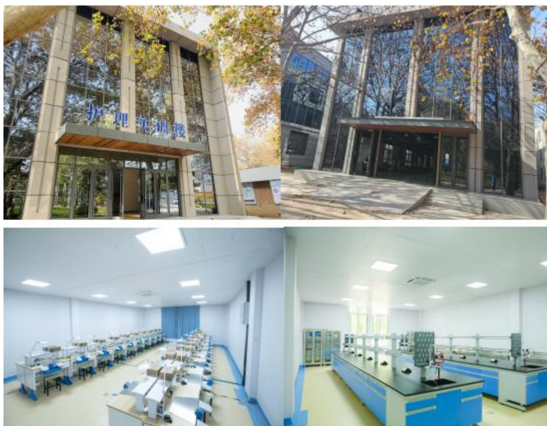
图 5-2 护理实训楼、智能工实训楼实景图
