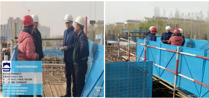
图 6-2 学院纪委书记魏国瑞同志、副科长锁静同志及后勤保障处处长张芳林同志前往图书综合楼项目建设现场进行检查督导
