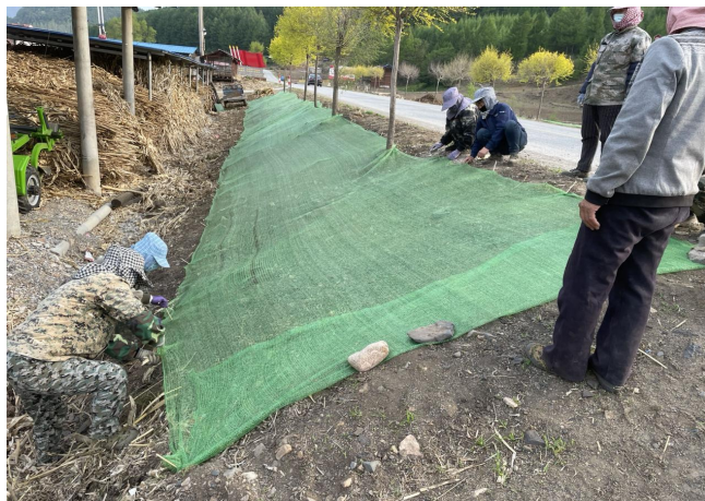
图 26 乡村街边环境治理现场
