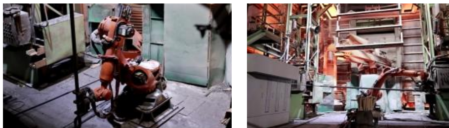
图 48 板材炼钢厂精炼测温取样机器人项目 PC 总承包项目
