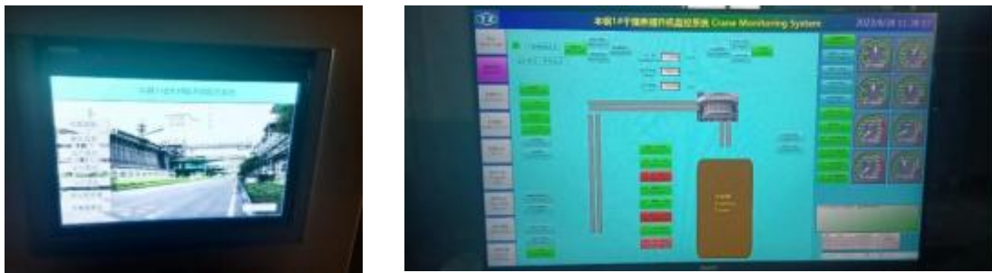
图 50 板材炼铁总厂 1#干熄焦提升机控制系统升级改造项目
