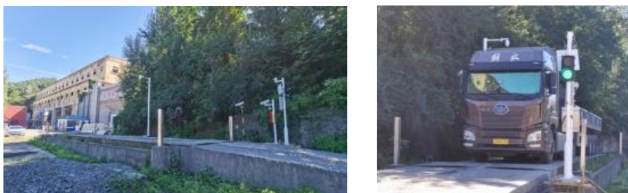
图 49 储运中心计量系统迁移项目
