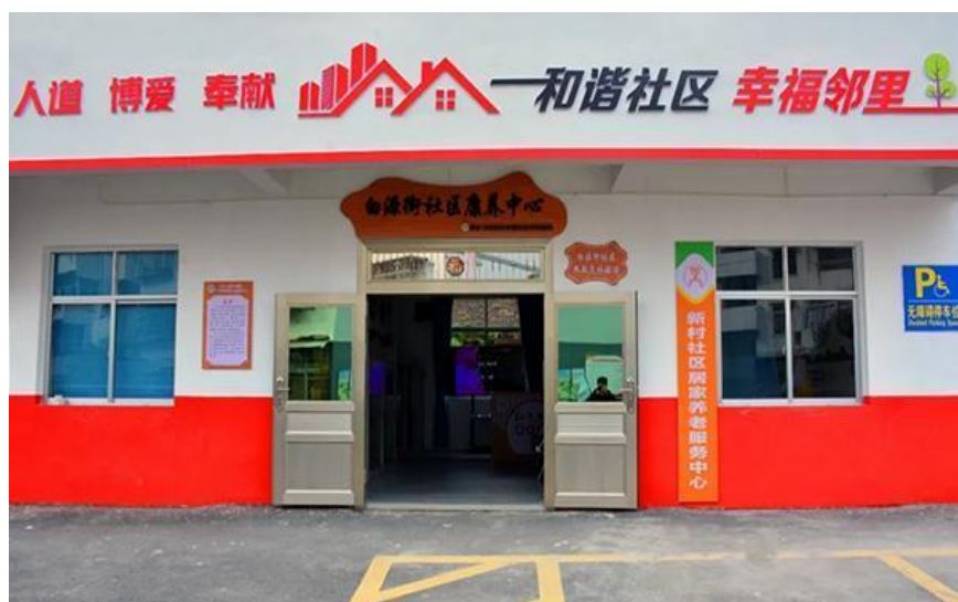
图 1-6 白源街社区康养中心项目
