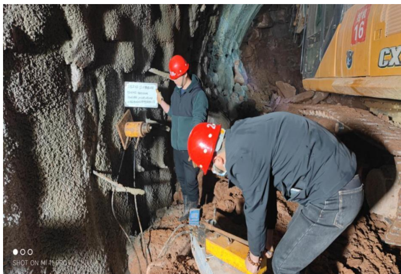
图 3-14 技术人员隧道检测
