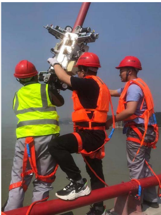
图 28 缆索智能检测机器人在鄱阳湖大桥等 20 余座桥梁进行检测
