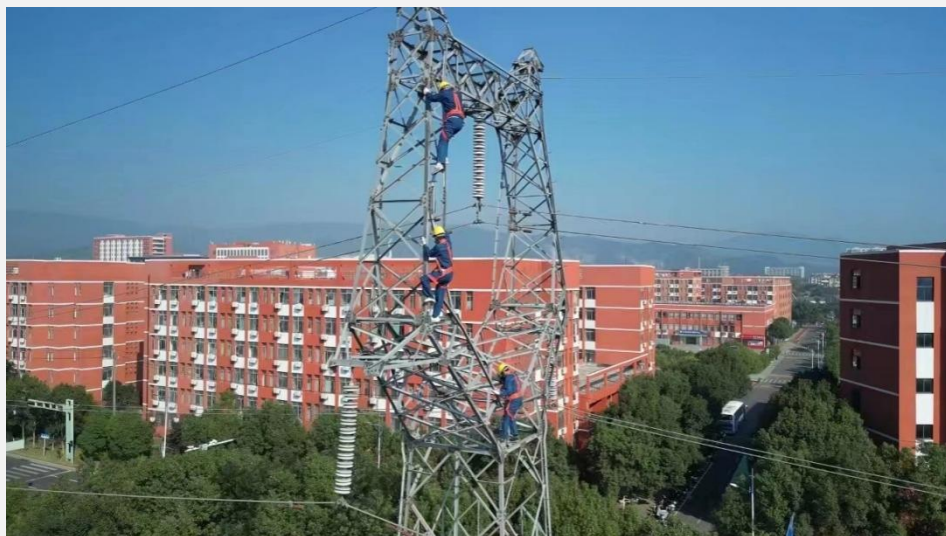
图 3-6 学院为国网江西公司员工开展高压输配电线路运检高空作业培训
