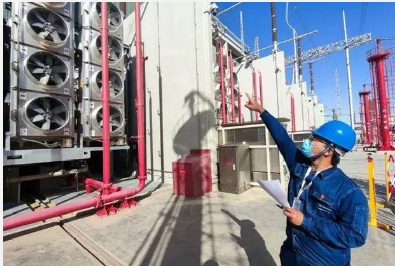
图 2-13 王玉强在±1100 千伏昌吉特高压换流站检修设备
