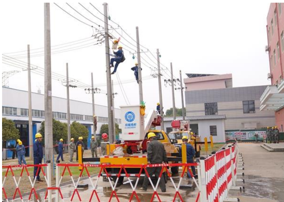
图 3-4 学院为供电服务公司员工开展 0.4kV 带电作业现场模拟教学
