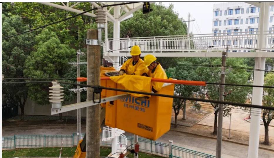
图 6-7 智慧供用电产业学院学生在开展配网带电作业现场检修实训
