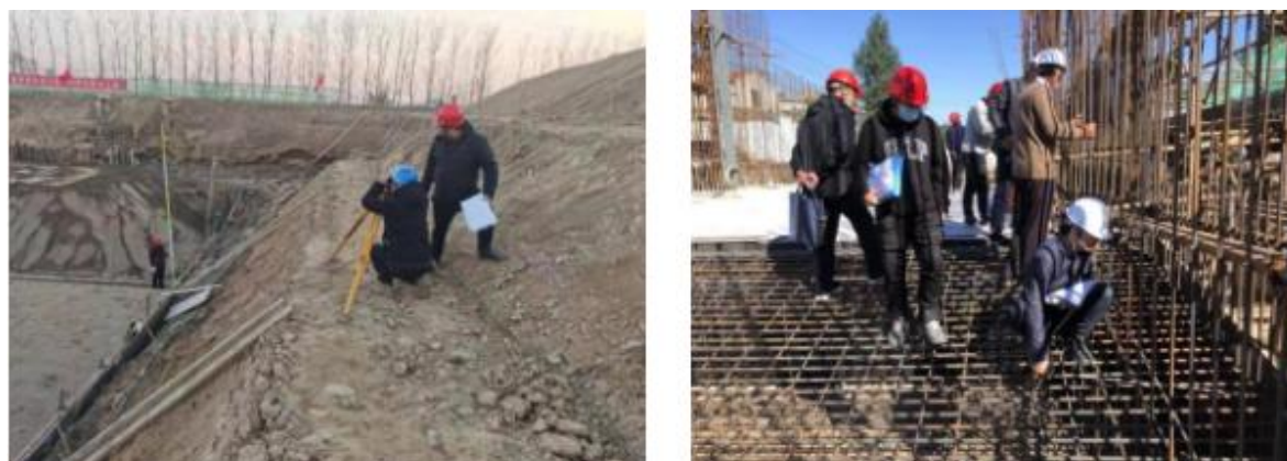
图 4-7 建设工程管理专业学生张弛在建筑工地实习图
