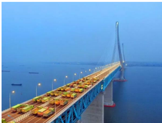
沪苏通大桥实景图
