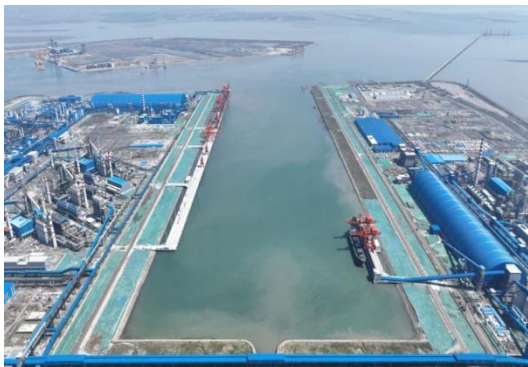
南通港吕四港区东灶港作业区一港池通用码头
