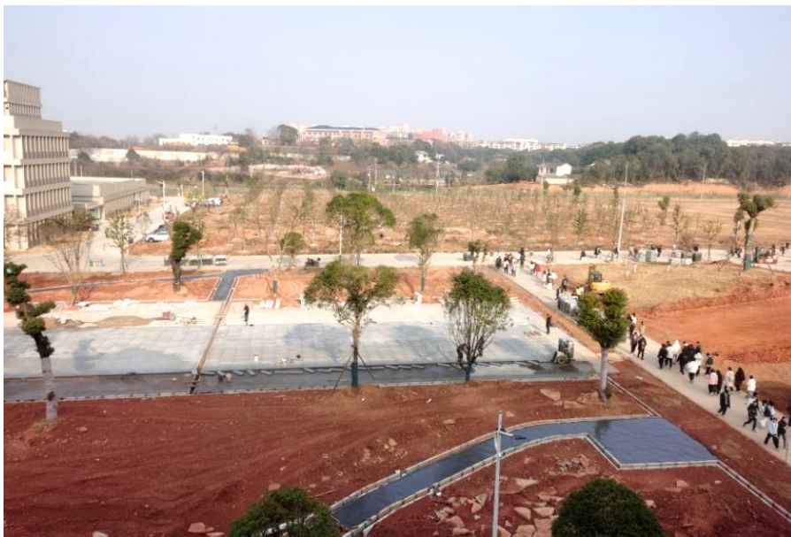
学校天心北校区中心广场建设
