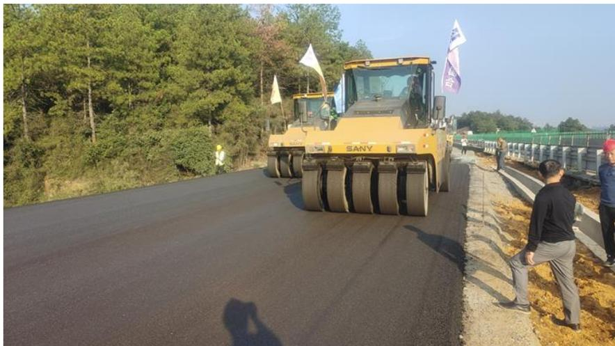
图 2-2 冷拌冷铺耐久性高性能沥青混凝土面层技术铺设的路面
