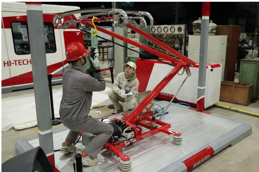
图 2-7 学校学生在第 46 届世界技能大赛中国集训基地进行受电弓检修技能训练
