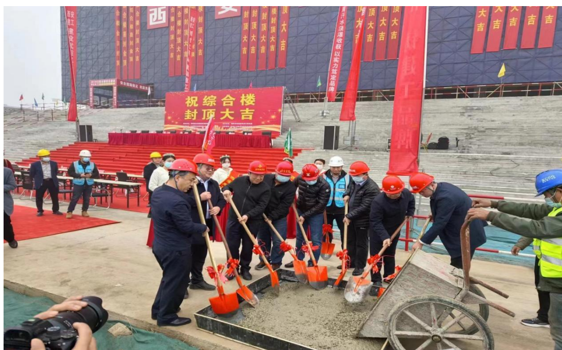
图 1-5 濮阳石油化工职业技术学院新校区综合楼封顶现场
