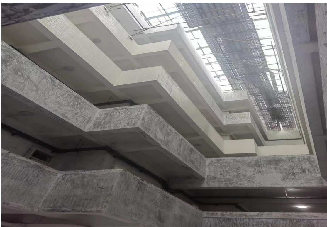
图 69.学院内外墙维修改造
