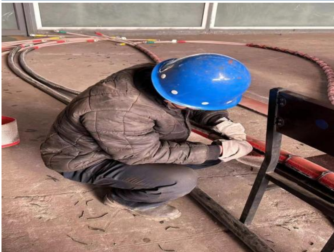
图 73 学生顶岗实习现场图
