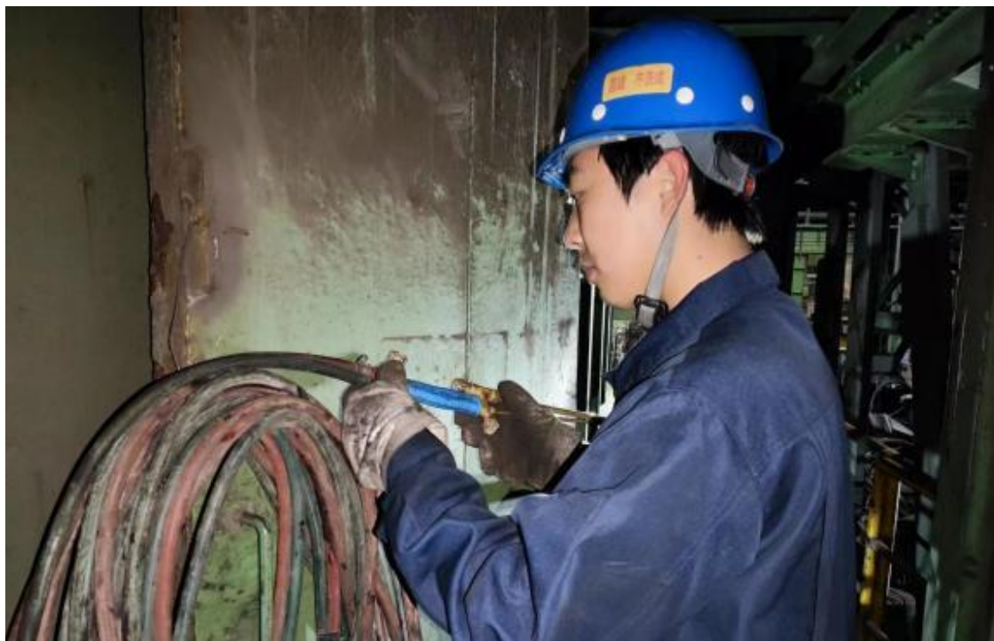
图 72 学生顶岗实习现场图
