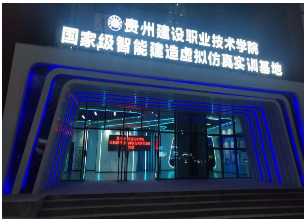
图 5.4 智能建造虚拟仿真实训基地
