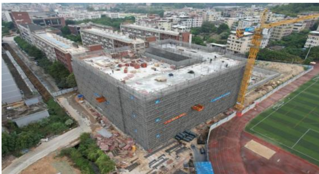
图 92 广州校区新建学生宿舍施工现场
