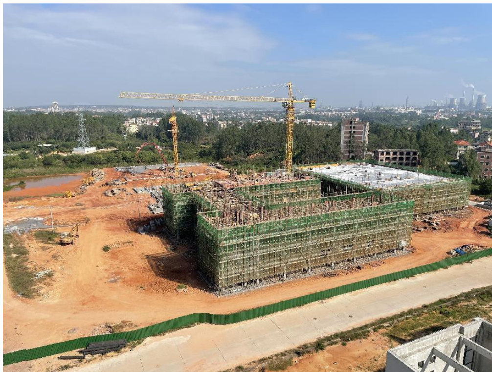
图 6-5 学校二期工程建设现场
