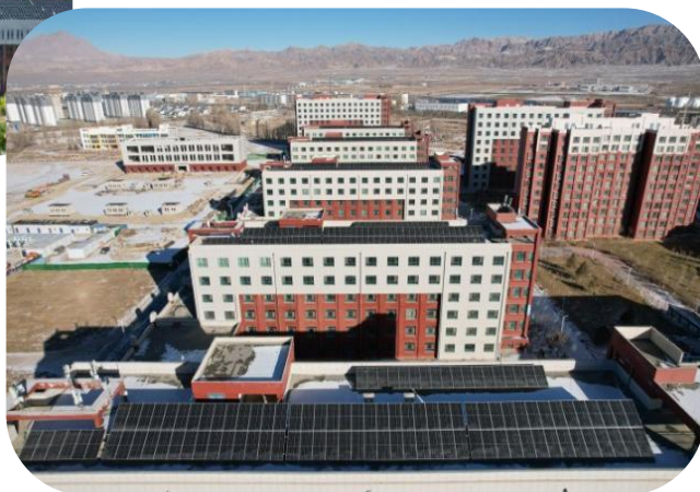
图 1-36 屋顶光伏组件
