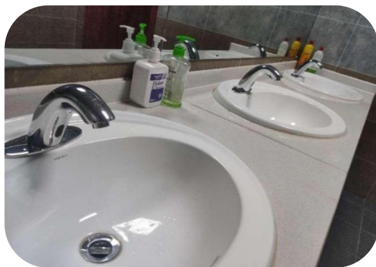
图 1-34 安装节水型器具
