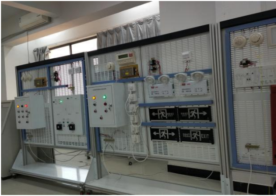
图 6-6：校企共建消防实训室
