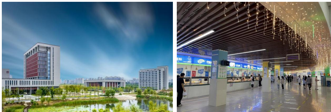
图 1.5-4 学院新建的宿舍与改造升级后的学生食堂
