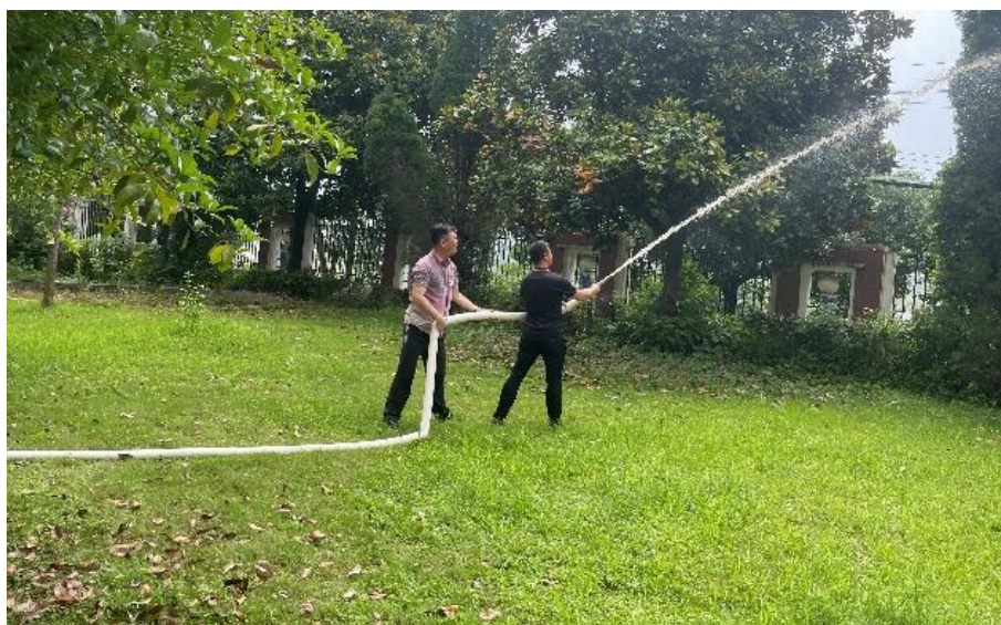
图 176：教职工积极投入消火栓实操出水测试
