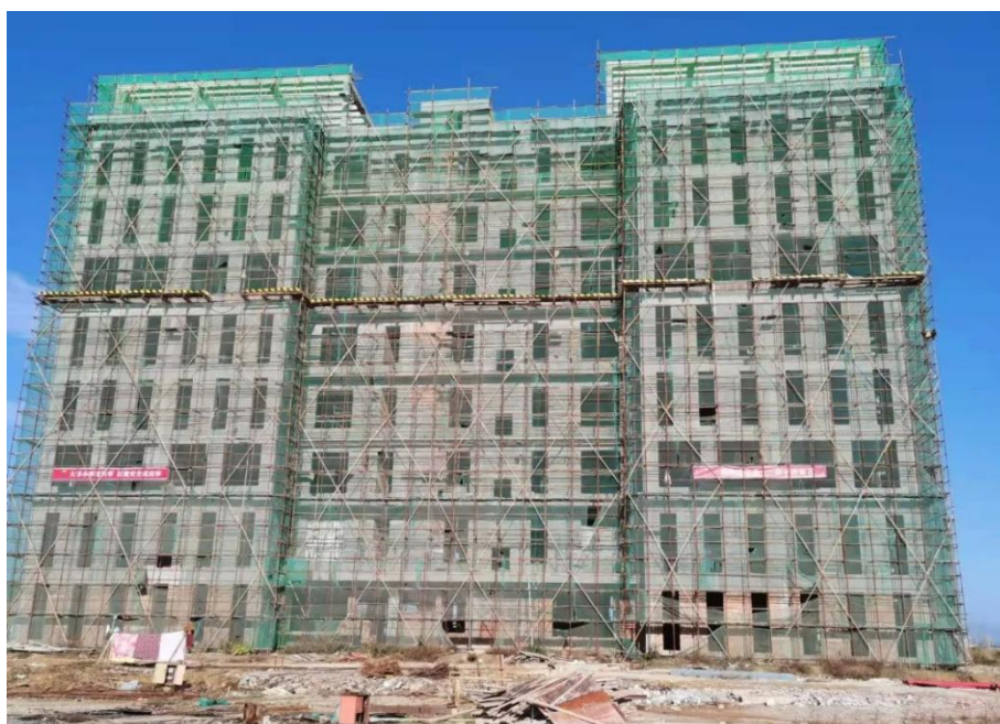
图 179：建设中的产教融合实训基地
