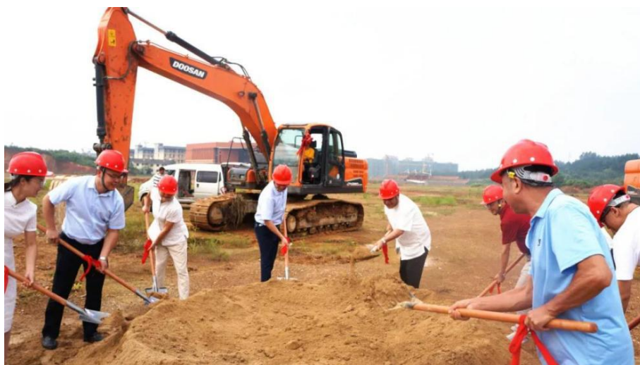
图 178：产教融合实训基地开工现场
