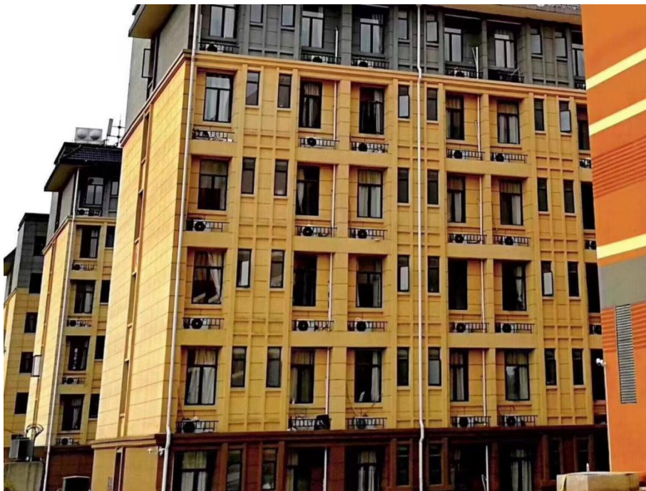
图 181：投入使用的新宿舍楼
