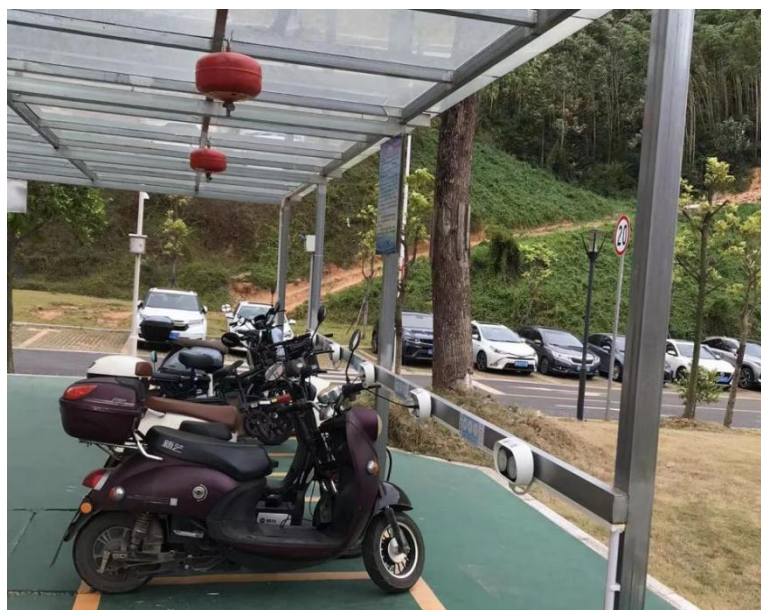
图 2-14 清远校区建设电动车充电站
