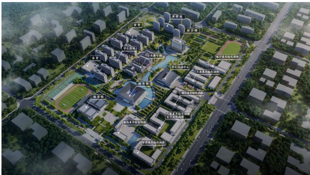
图 2-12 建设中的学院新桥校区
