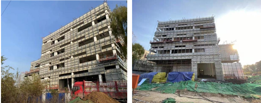
图 35 跨企业培训中心现场施工实景
