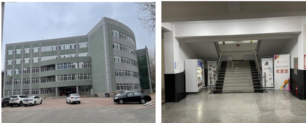
图 37 F 座教学楼维修改造项目实景
