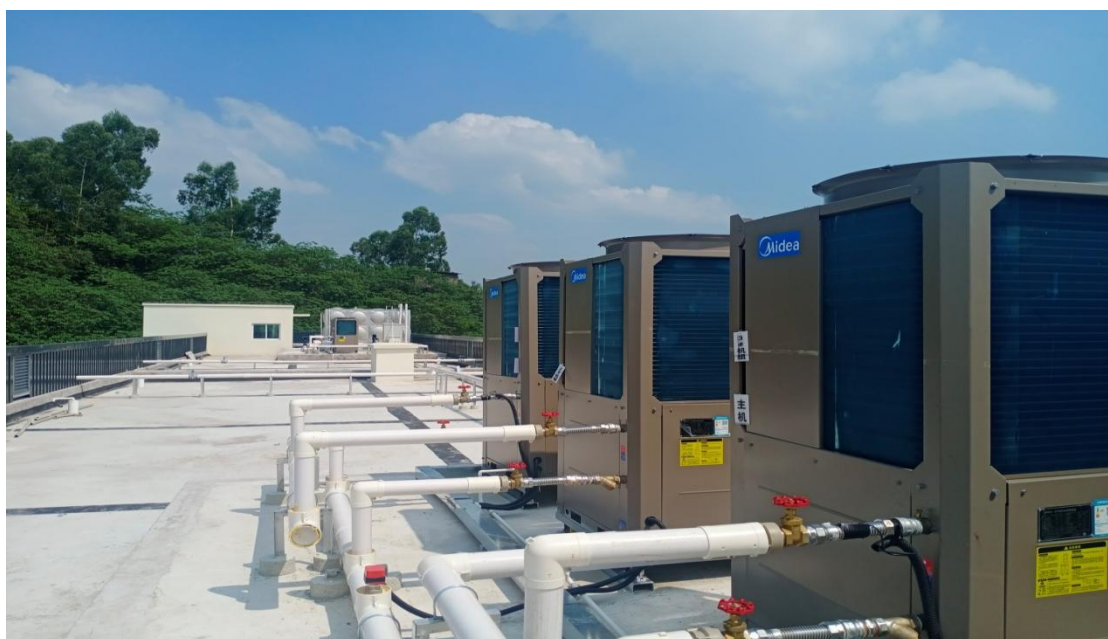
图 10 改造后的空气源热泵热水系统
