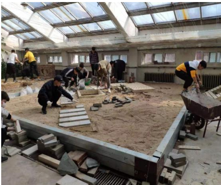
图 3-13 园林学院的园林工程施工实训中心
