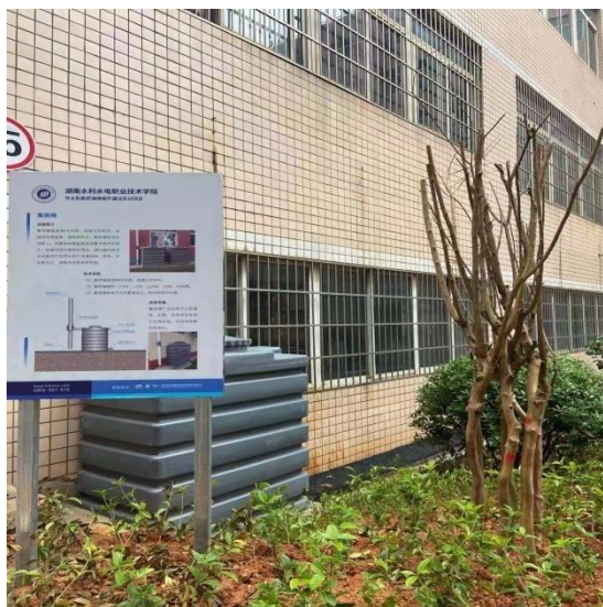
图 5-7 雨水槽（屋顶雨水利用）
