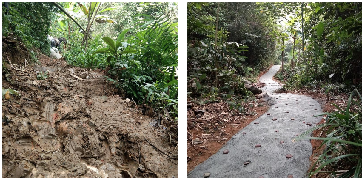
图 6-3 通往盘王谷道路建设前后的照片
