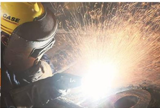
图 3-17 工程机械项目施工现场
