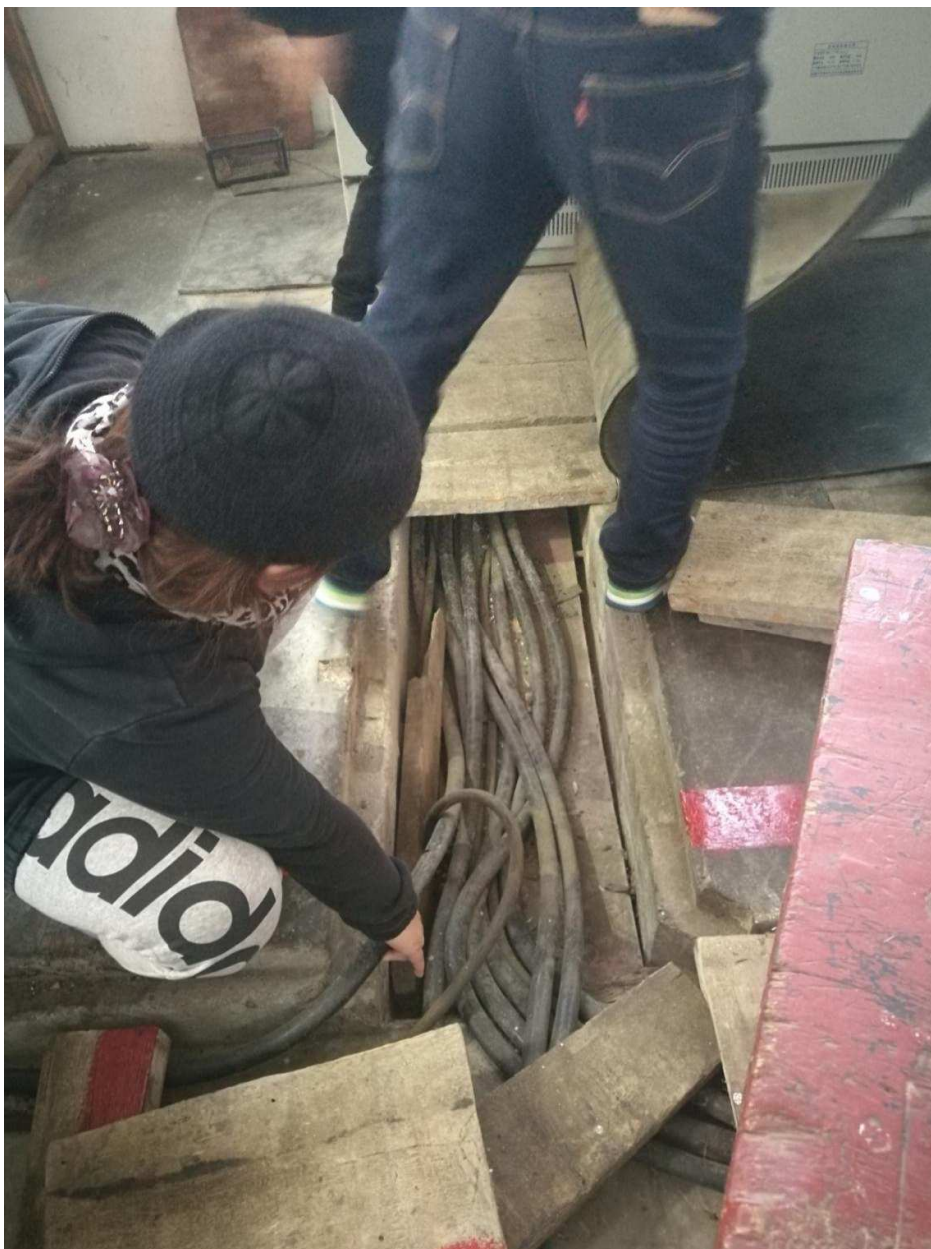
虹桥关电站现场踏勘[周宏伟]
