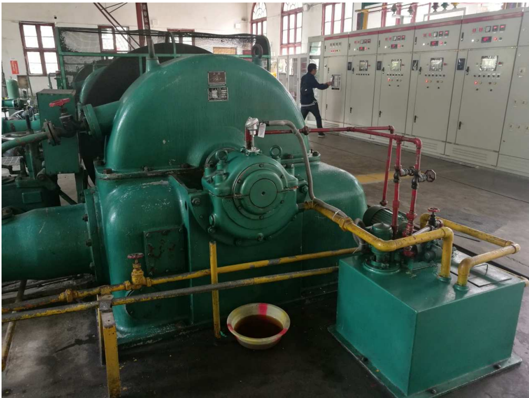
独松二级电站现场踏勘[杨泽江]
