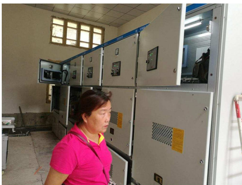
启动试运行前设备安装验收[周宏伟]
