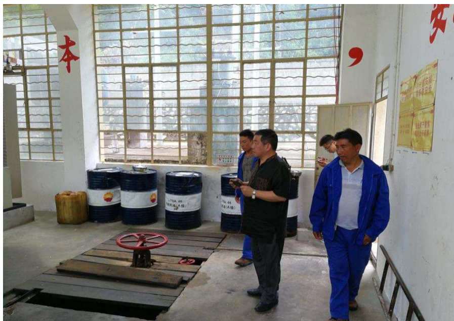
冕宁县朝阳电站厂房现场踏勘
