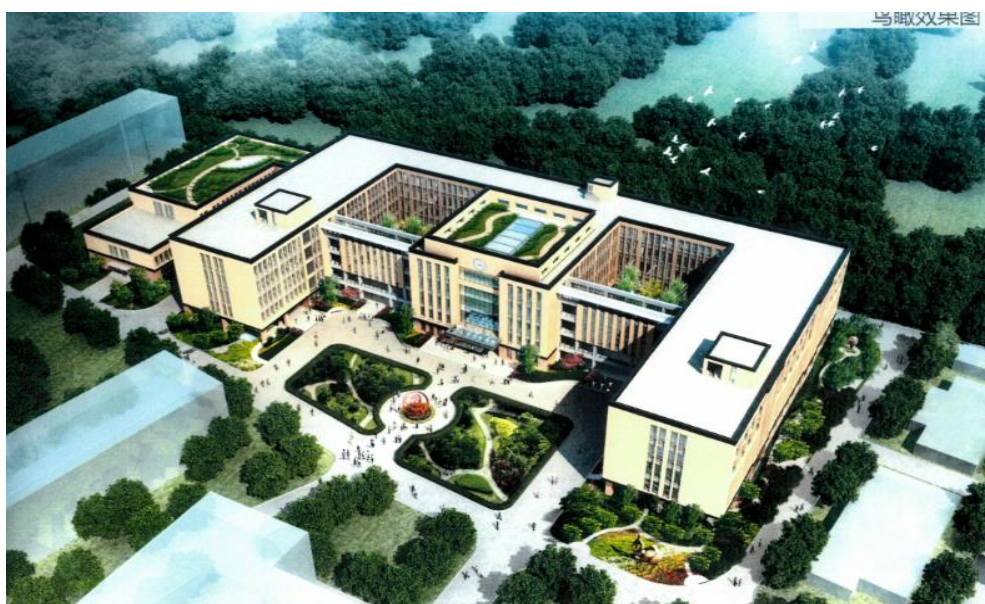
新建实训大楼鸟瞰图
