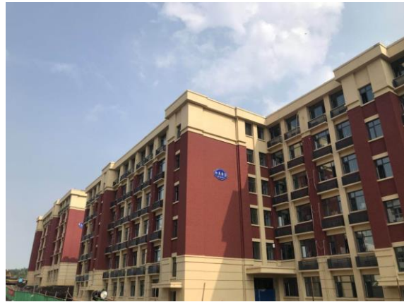
新建成的学生公寓楼
