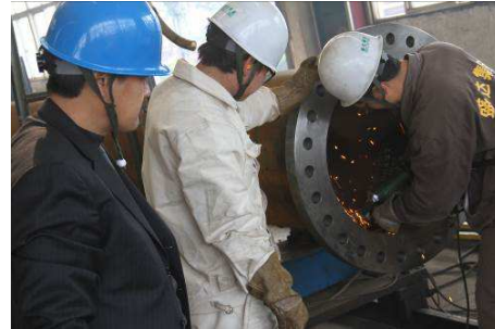
第三方检测现场
