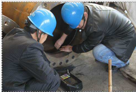
第三方检测现场
