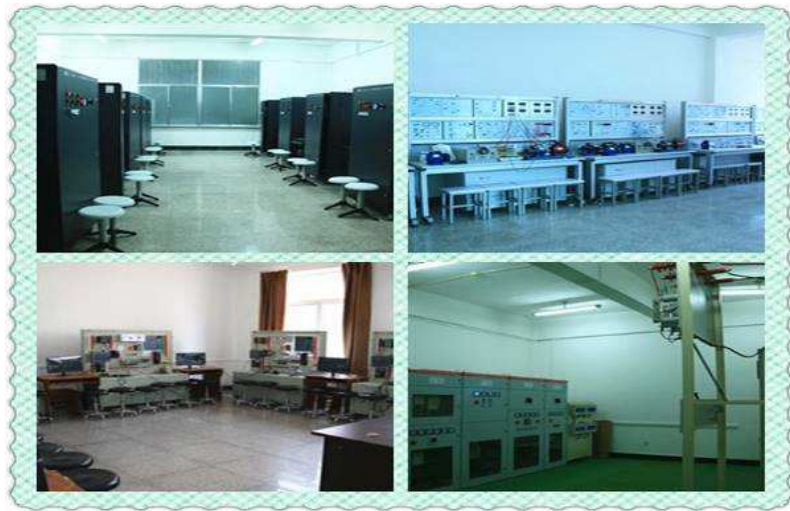
图 2-18 电工电子与自动化技术实训基地
