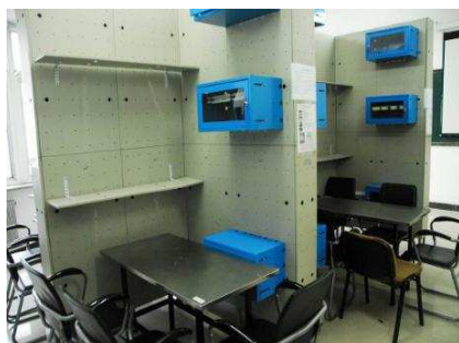
综合布线实训室
