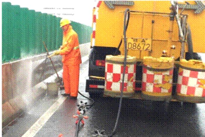
图 39 高压冲水管拖载装置在朝阳大桥的使用
