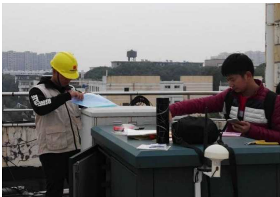
图8 江西电信基站建设项目
