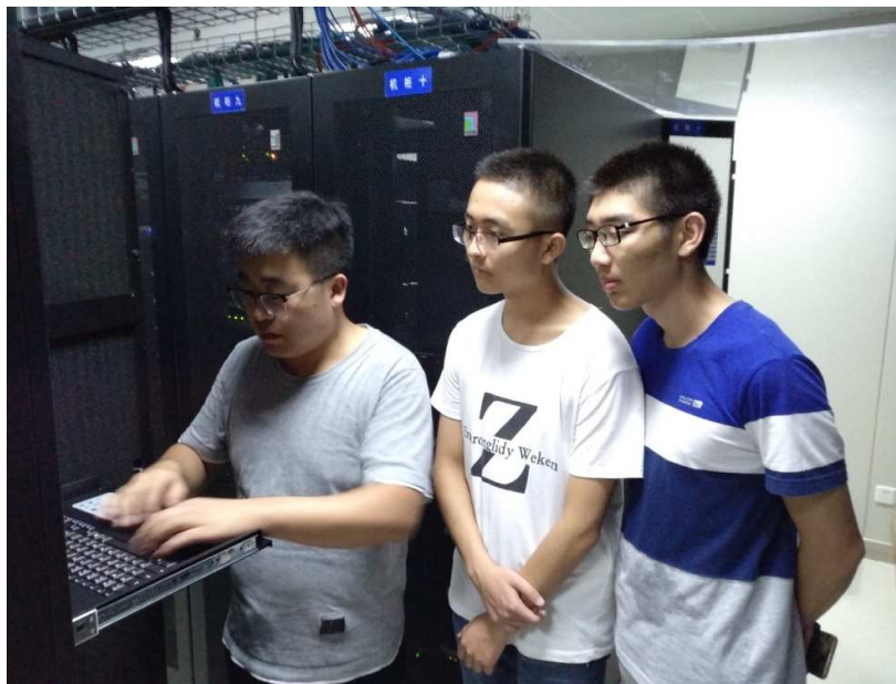
图 3-6 2016 级通信技术专业“杰出人才班”学生在省气象局数据中心进行数据配置
