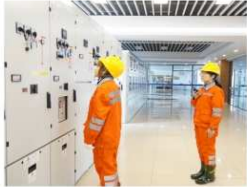
图 3-32 学徒进行三工位开关倒闸操作训练
