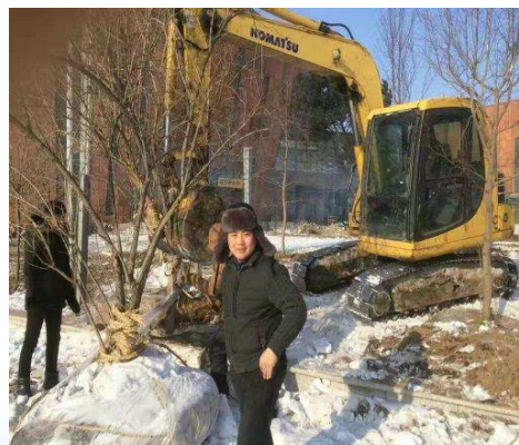
马游在施工现场
