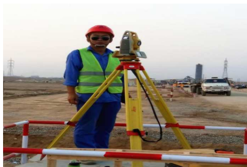
图 2-27 宁新龙利用全站仪进行施工测量
