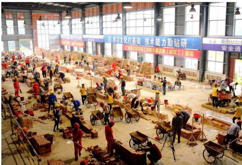
图 5-4 广西第五届农民工技能大赛决赛砌筑工比赛现场
