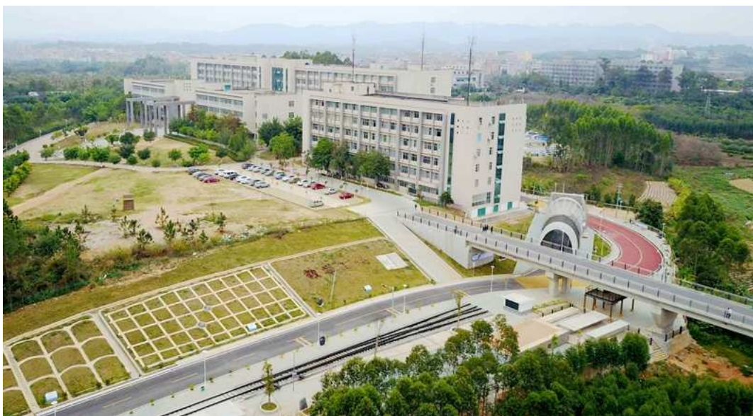
图 11 教学工场全景图
