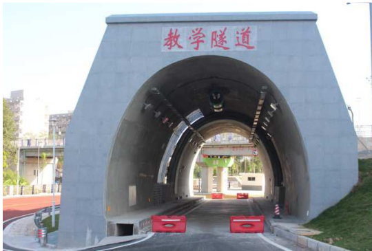
图 20 路桥教学工场教学隧道
