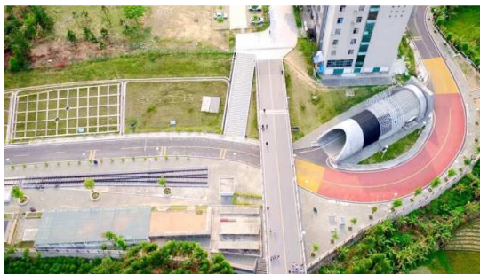
图 18 路桥教学工场俯视图
