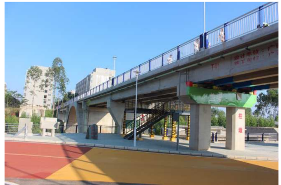
图 21 路桥教学工场教学桥梁
